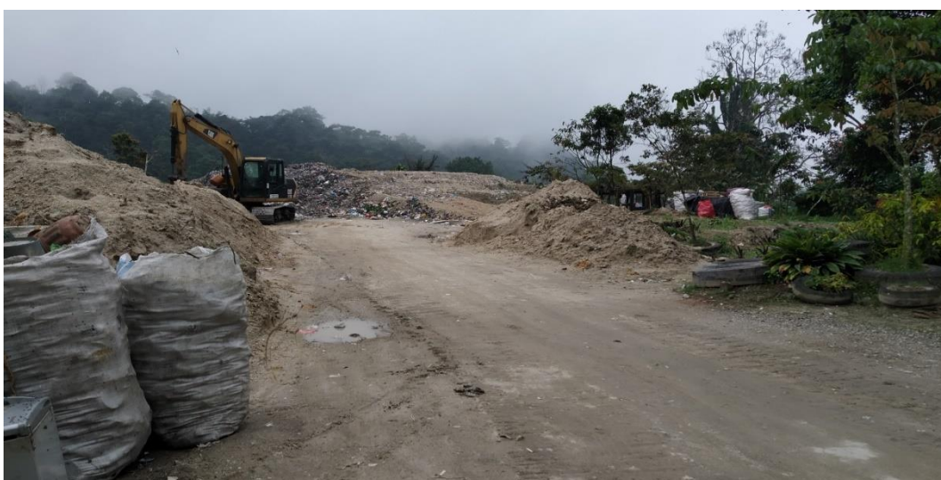
Gambar 5.7D Lokasi Operasional Zona 3
